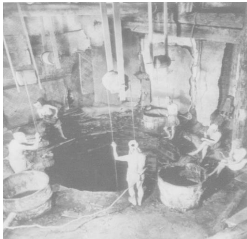
图 4-10 保留至今的西汉白兔井（大口井采卤、重庆云阳） （转摘自《中国科学技术史·图录卷》）
